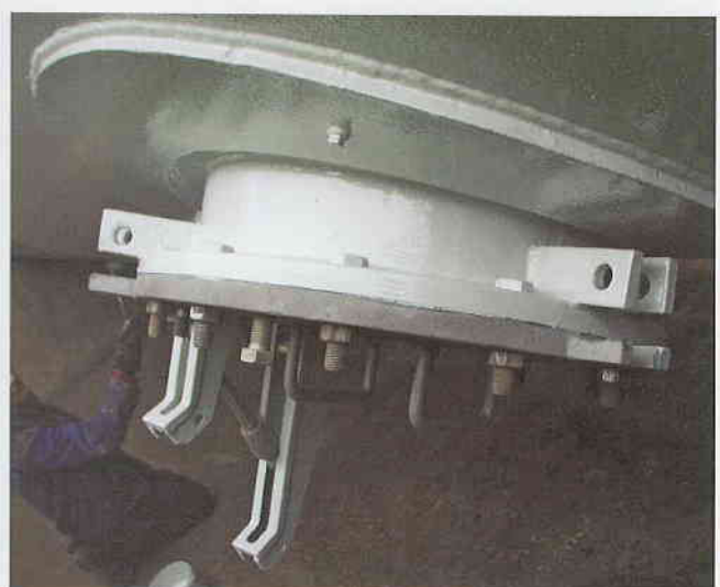
Testbeschichtung einer Triebwasser-Pipeline mit einem 1K-PUR-System. Die dauerhaft zäh-elastische Struktur der Beschichtung bietet einen Korrosionsschutz mit hoher mechanischer Stabilität und Abriebfestigkeit.
