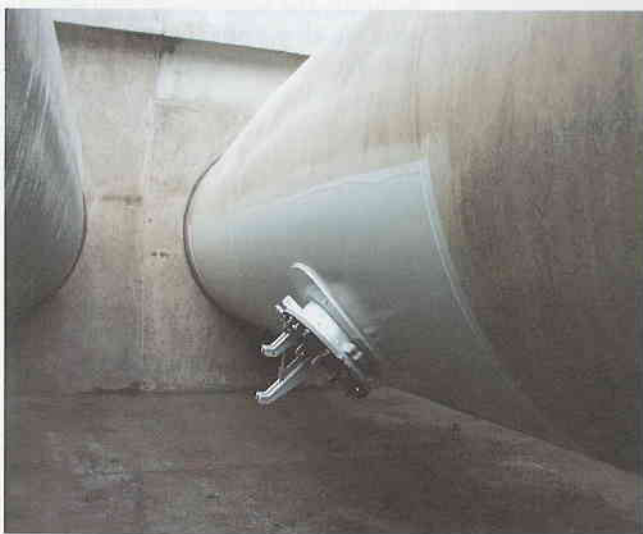
Testbeschichtung einer Triebwasser-Pipeline mit einem 1K-PUR-System. Die dauerhaft zäh-elastische Struktur der Beschichtung bietet einen Korrosionsschutz mit hoher mechanischer Stabilität und Abriebfestigkeit.
