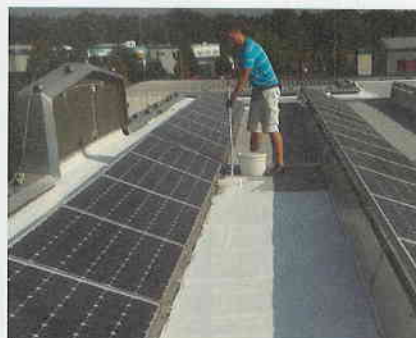
Schnell und unkompliziert lässt sich die weiße Reflexionsfarbe auftragen.
